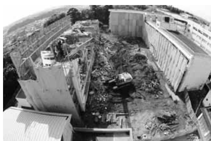
旧3号館取り壊し中
